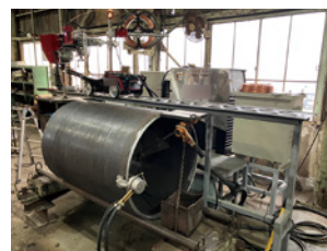
新規溶接機による厚板溶接
