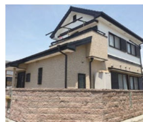
WBアート施工実績
