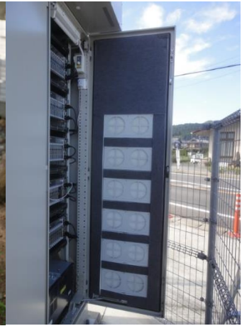
屋外キュービクル
